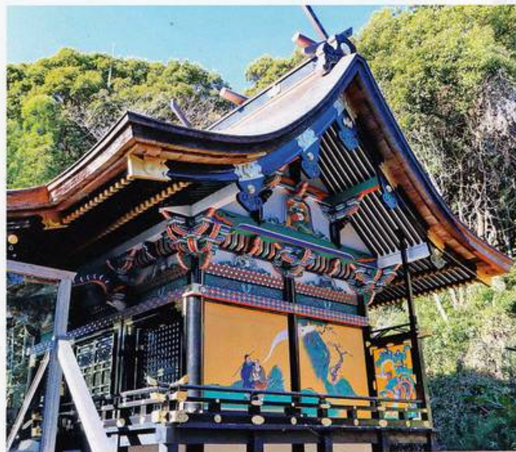
朝倉神社本殿東から
