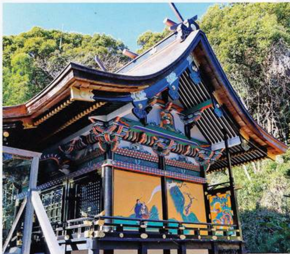
朝倉神社本殿東から
